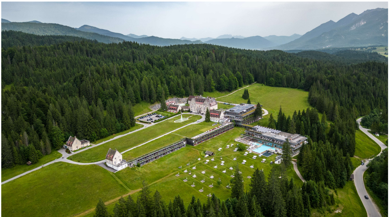
Abb. 14 Blick von Südwesten auf die Hotelanlage, Quelle: Hotel Kranzbach 2023
