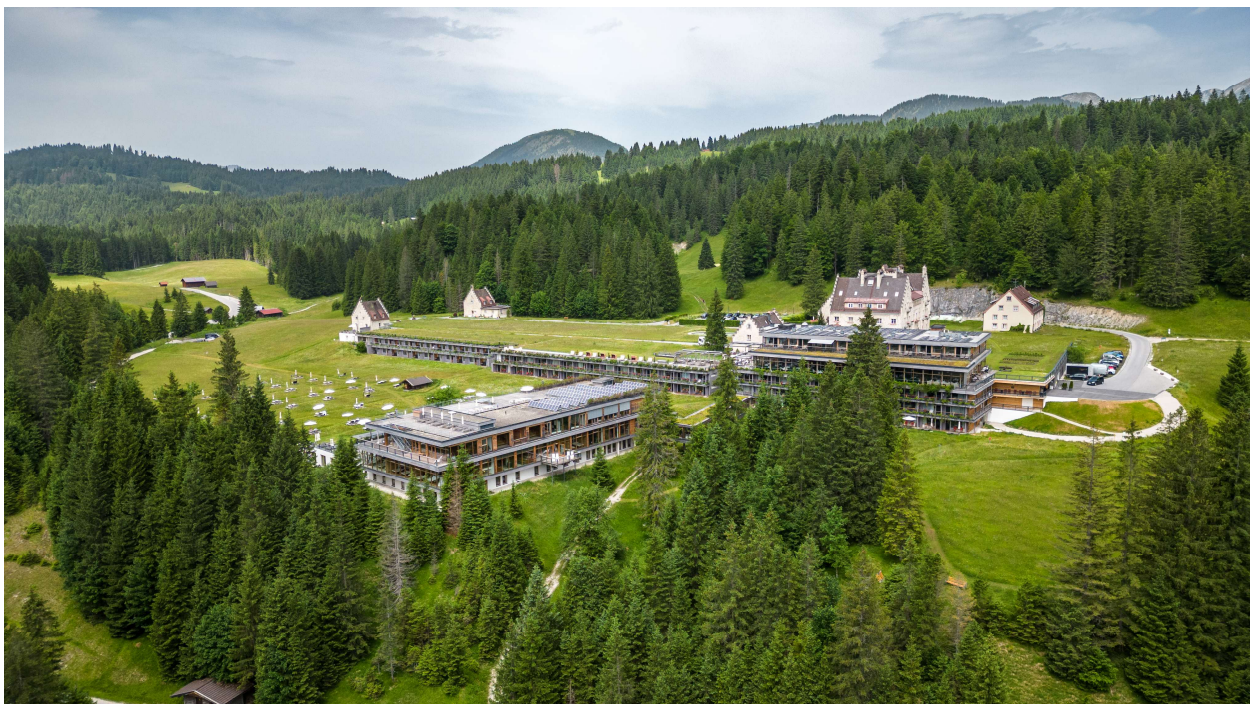
Abb. 16 Blick von Südosten auf die Hotelanlage, Quelle: Hotel Kranzbach 2023
