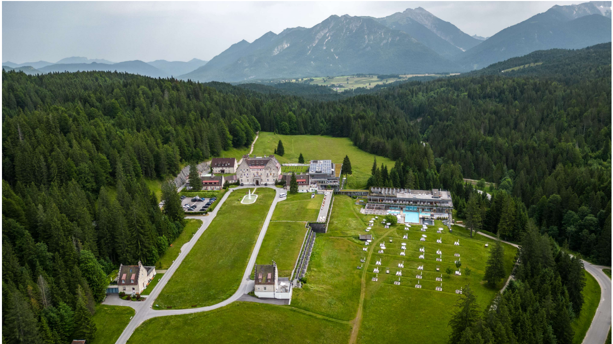
Abb. 13 Blick von Westen auf die Hotelanlage, Quelle: Hotel Kranzbach 2023
